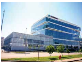
Administrativni kompleks AO Forte banke, Astana, Kazahstan
