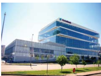
Administrativni kompleks AO Forte banke, Astana, Kazahstan
